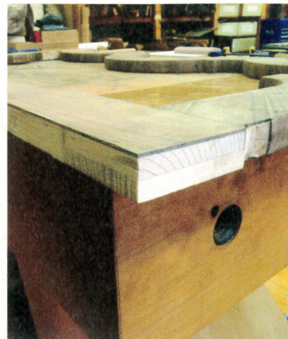
Les angles assemblés par recouvrement.
