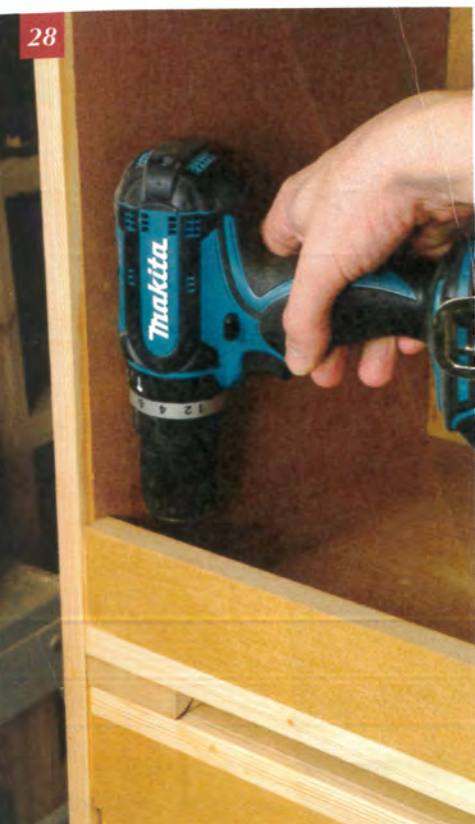
Les cales de maintien de la table de défonceuse sont collées, puis vissées dans la structure.
