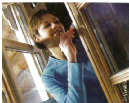
▲ Les vernis s'appliquent au pinceau plat ou au spalter et sont tirés dans le sens des fibres du bois.
