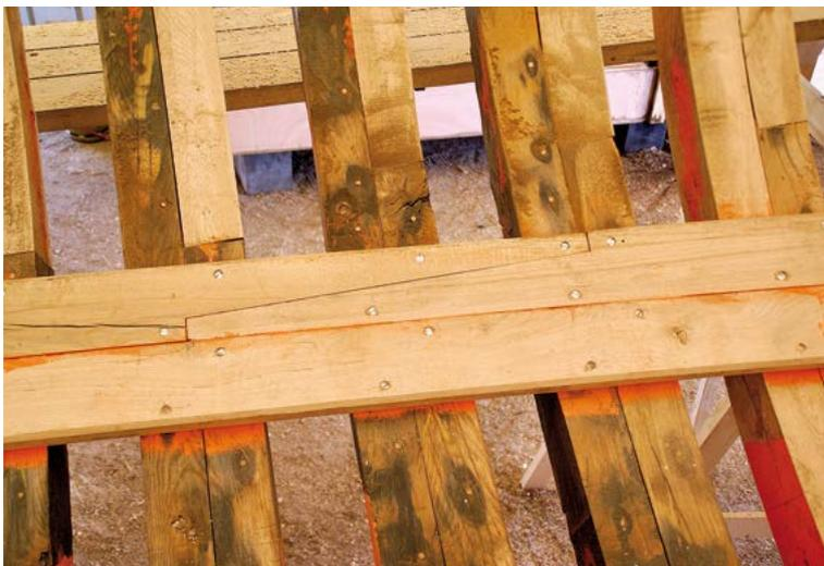
Exemple de trait de Jupiter simple, ici sur une serre d'« empature », c'est-à-dire un élément longitudinal renforçant la structure à l'intérieur des membrures
