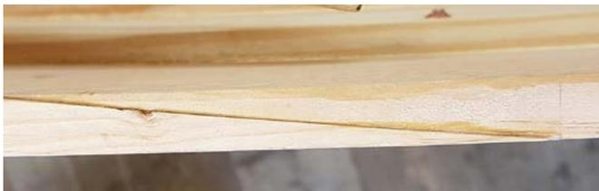
Scarf collé d'une virure de bordé, vu sur chant. La longueur du scarf est de 8 à 10 fois l'épaisseur environ
