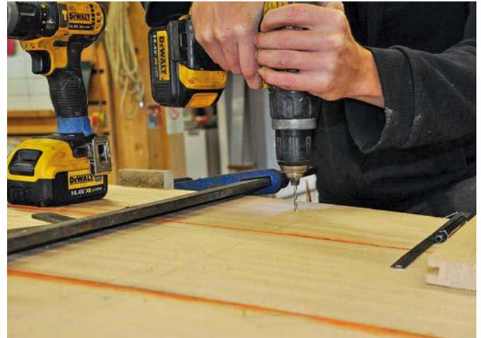
La sole est vissée dans les varanques, un grand serre-joint transversal maintenant l'assemblage. On pourra appliquer un joint d'Ettan sur les surfaces de contact
