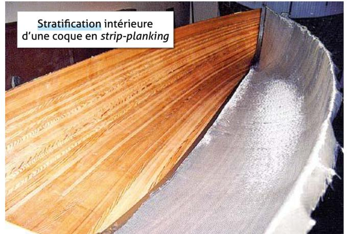
Stratification intérieure d'une coque en *strip-planking*
