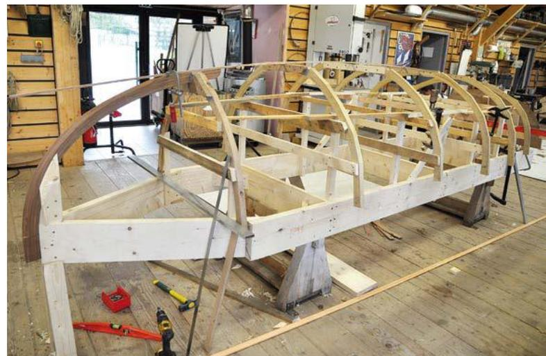
L'étrave repose sur le pied avant du chantier, avec un vissage provisoire, et la membrure 6, par collage. Vérifier la continuité du plan de pose de la sole qui vient tout recouvrir
