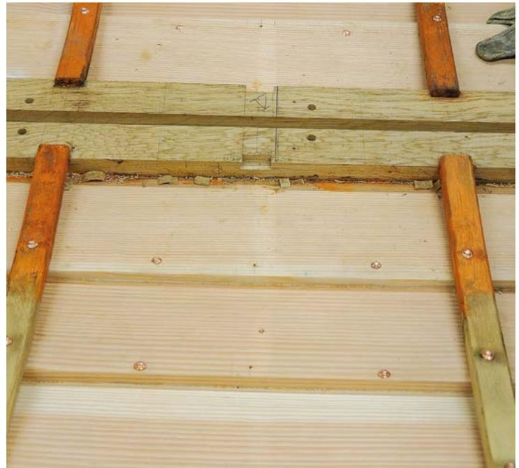
On trace à l'avance la position des membrures, de façon à pré-percer le bordé par l'intérieur. Dans le cas présent d'un bordé à clin, les rivets doivent être aux points de contact de la membrure avec le bordé. Décaler alternativement les perçages pour réduire le risque de fendre la membrure
