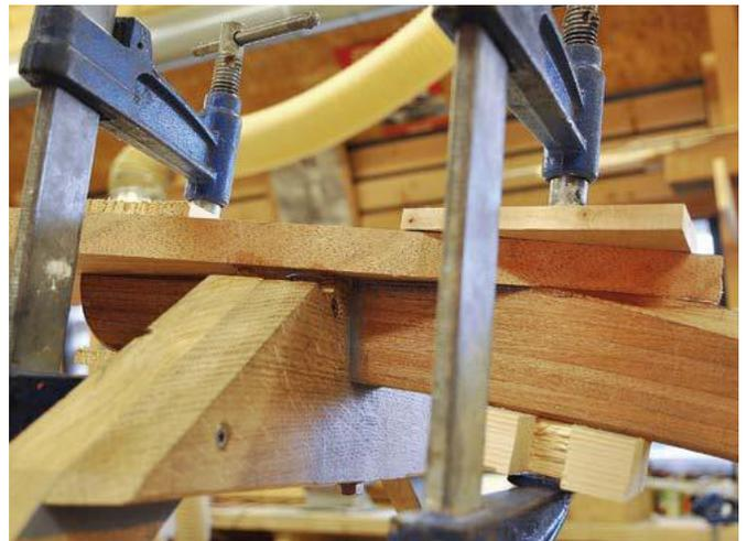
À l'avant, la sole est collée (mastic-colle polyuréthane) et vissée sur l'étrave. Même chose sur la base du tableau
