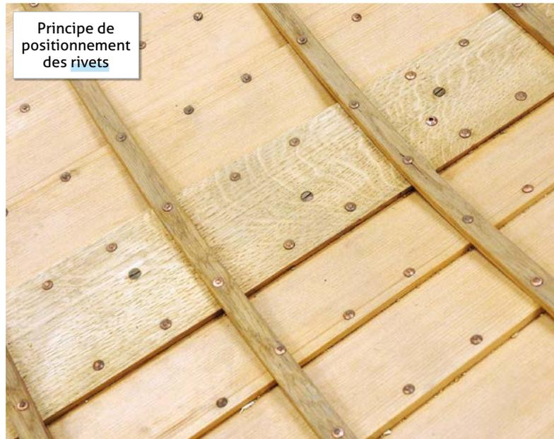
Principe de positionnement des rivets
