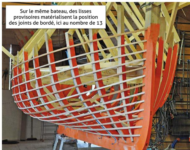
Sur le même bateau, des lisses provisoires matérialisent la position des joints de bordé, ici au nombre de 13
