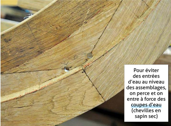
Pour éviter des entrées d'eau au niveau des assemblages, on perce et on entre à force des coupes d'eau (chevilles en sapin sec)
