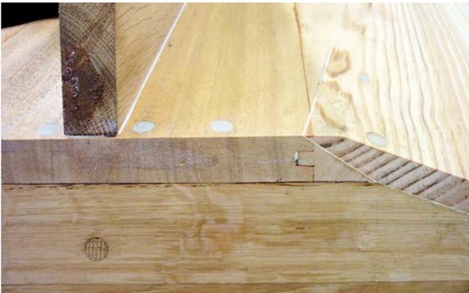
Cette vue de l'arrière, à un stade ultérieur du montage, montre l'équerrage de la sole sur laquelle le galbord vient s'ajuster. Le joint bouveté est bien visible, avec son fil de coton (tout petit point blanc !)
