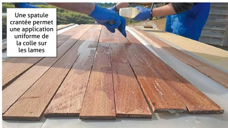
Une spatule crantée permet une application uniforme de la colle sur les lames
