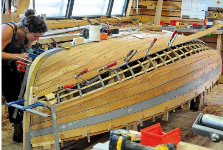
Ce *Morbic 12* est construit à l'envers. Un mannequin réutilisable muni de lisses a permis de poser les membrures ployées avant le bordé
