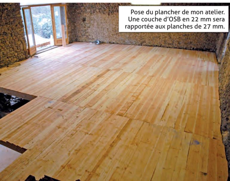
Pose du plancher de mon atelier. Une couche d'OSB en 22 mm sera rapportée aux planches de 27 mm.
