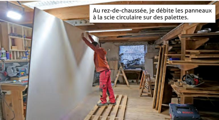
Au rez-de-chaussée, je débite les panneaux à la scie circulaire sur des palettes.
