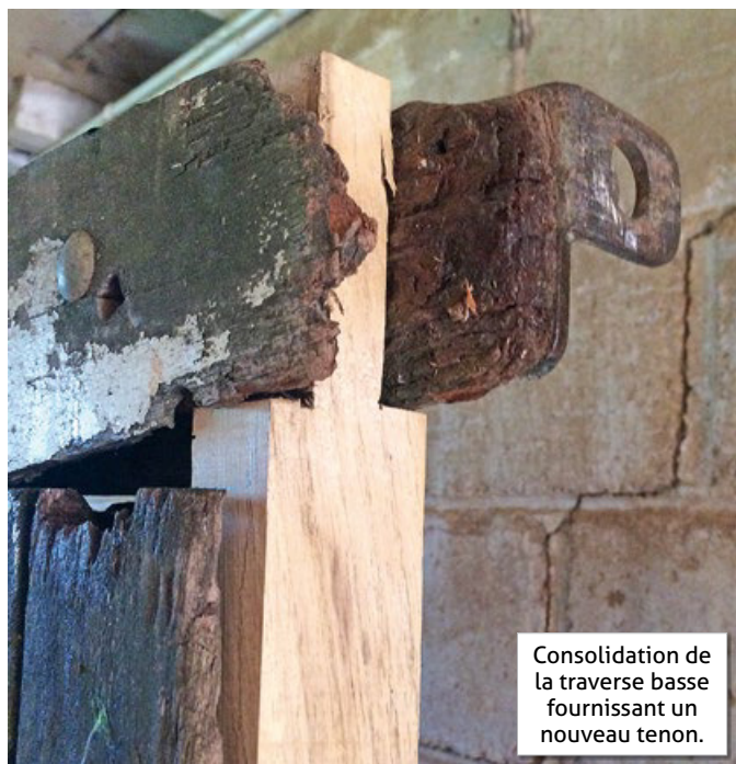
Principe d'origine d'assemblage de la partie basse du portail.
