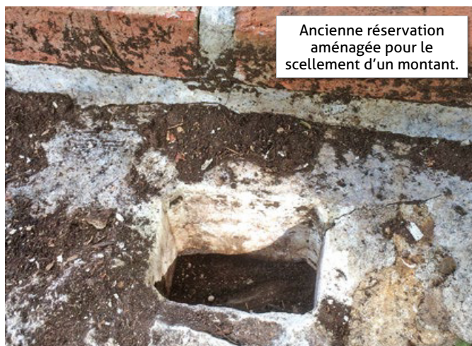
L'ancienne barrière était ancrée dans le muret, les pieds des montants pénétrant dans des réservations, vraisemblablement « coffrées » avec des portions de tuyau fibrociment de forme rectangulaire.
