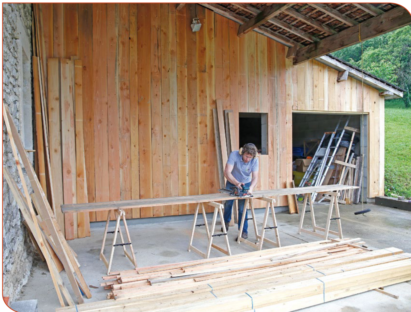
Chantier de travail sécurisé.
