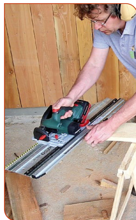
Tronçonnage en biais.
