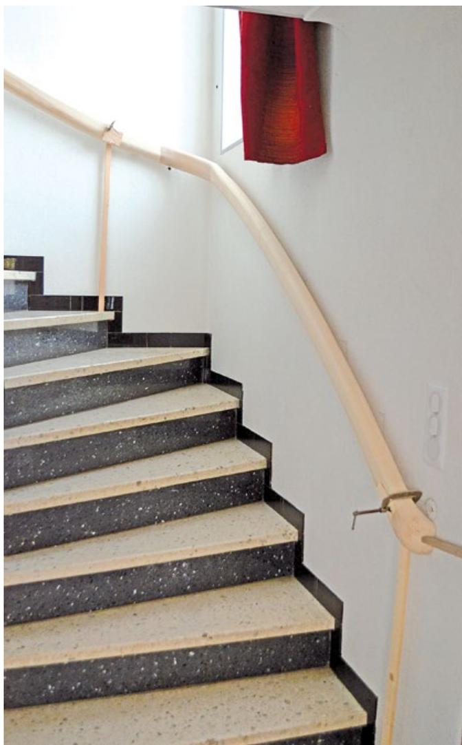
La première chose à faire, lors de la présentation, est de positionner les entretoises avec un ruban adhésif double-face façon à pouvoir tracer leur contour sur le mur (sans avoir mis les tiges filetées). Ensuite on repère l'emplacement des trous sur le mur et on perce au diamètre de 12 mm. Il faut penser à pratiquer des lumières horizontales dans la première volée (7 cm de large).
