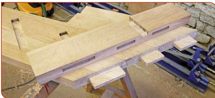
Les joues de ces tenons, à l'extrémité d'un limon d'escalier, ont été ébauchées avec une scie circulaire plongante en multipliant les traits de scie contigus, et finies avec un rabot n°62 (demi-varlope).
