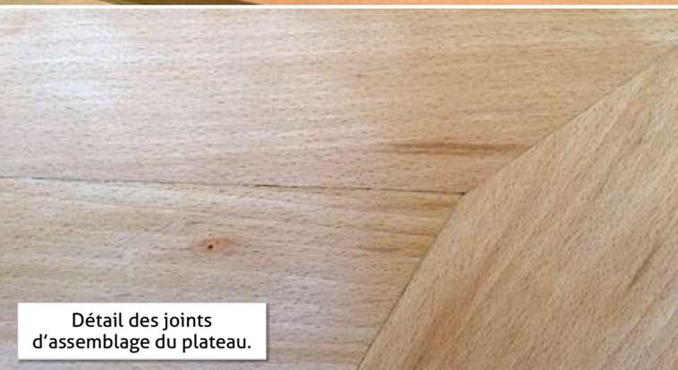
Détail des joints d'assemblage du plateau.
