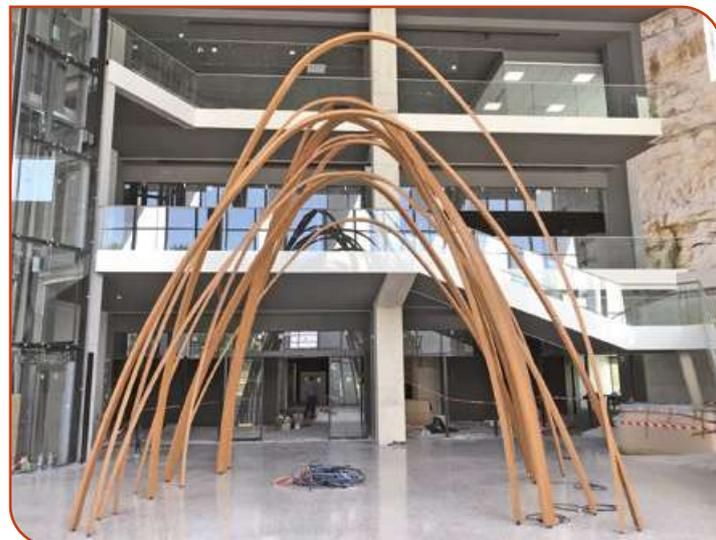
Arches de 6,30 m de haut en lamellé de chêne dans le hall d'une banque.
