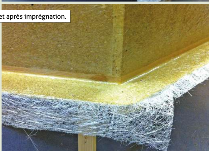
Renforcement d'un socle, par stratification, avec une première couche de tissu « mat de verre », avant imprégnation...
