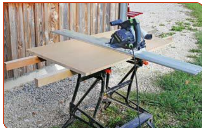
Chantier de découpe de fortune.
