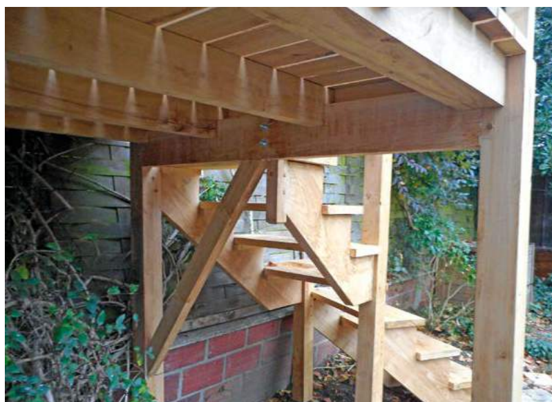
37 L'accès sous la terrasse est aisé
