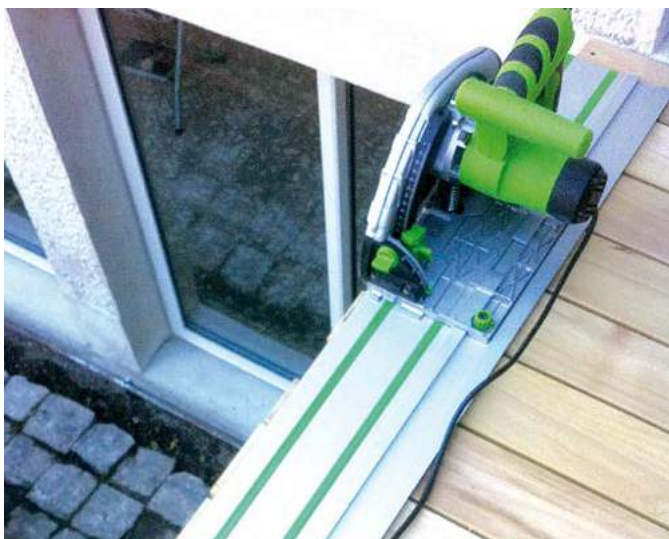
34 Recoupe des extrémités de lames à la scie plongeante
