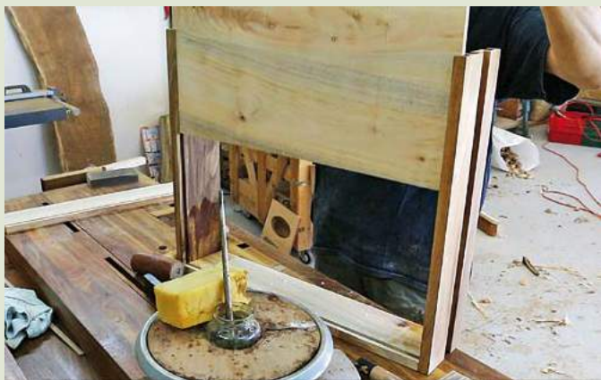
27 Ici, il faut glisser le panneau entre les deux façades
