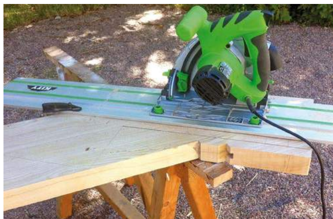
18 Amorce de la découpe des limons à la scie plongeante avec rail
