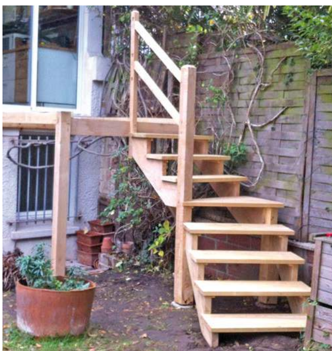
31 La seconde volée est en place et toutes les marches fixées
