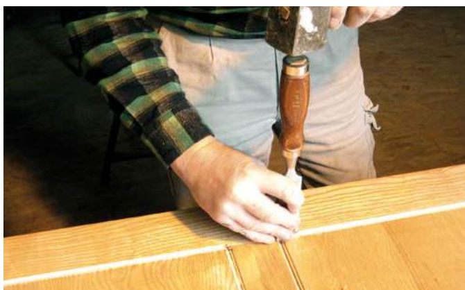
16 Finition des angles au ciseau à bois
