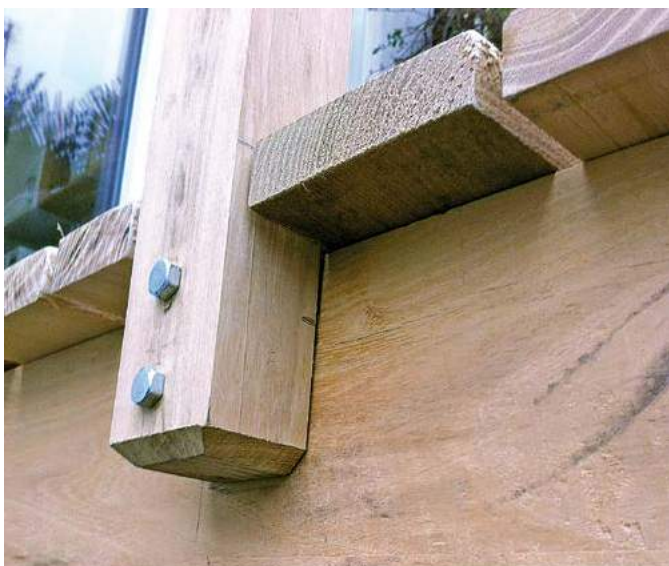
35 Deux tire-fonds en bas de chaque potelet permettent de fixer le garde-corps
