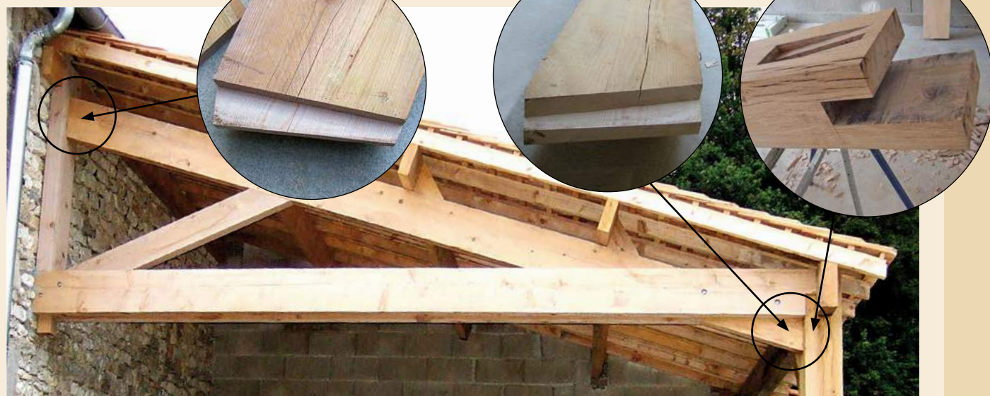
D Exemples d'embrèvements de charpente
