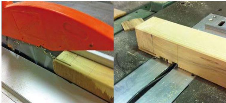
23 Usinage des encoches de positionnement des potelets
