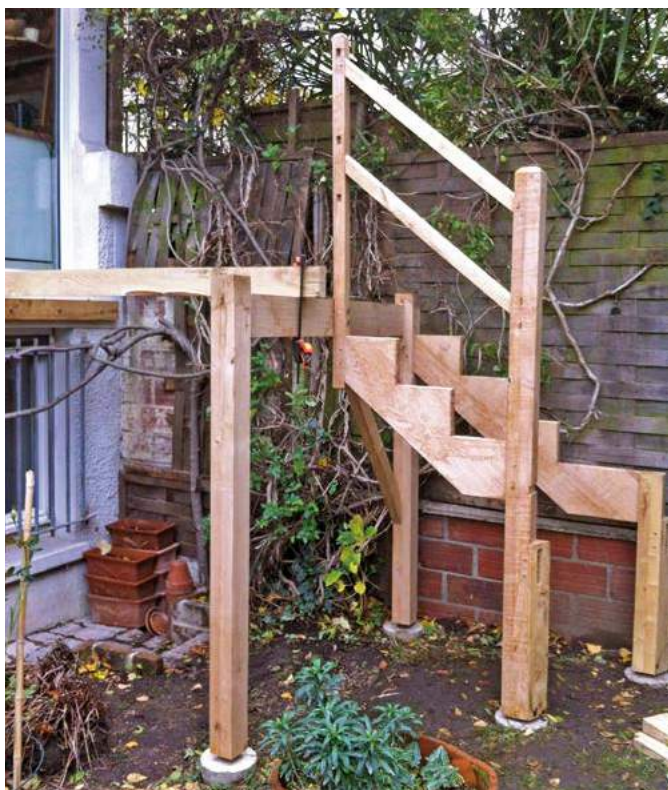
30 Assemblage sur site des éléments « préfabriqués »
