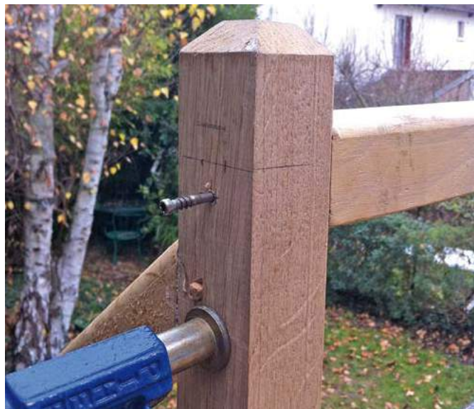
36 Fixation de la main courante sur le retour
