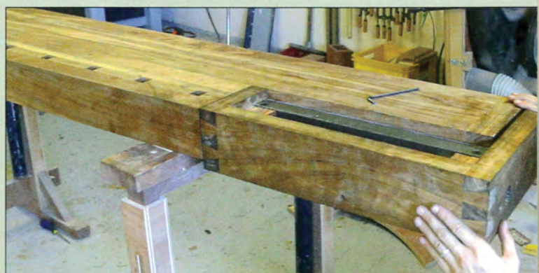
21 Je vérifie le bon alignement de l'ensemble avec le plateau
