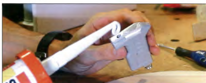
6 J'obture la canalisation avec du joint PU
