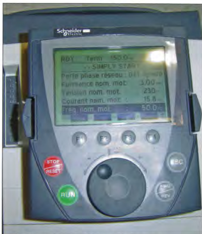
8 Tableau de commande et écran de paramétrage de mon variateur
