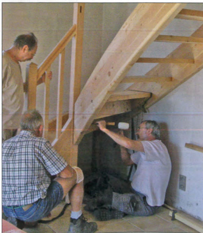
35 Il ne reste plus qu'à serrer les écrous !
