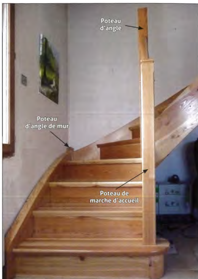
17 Mon escalier comporte également un poteau soutenant les deux faux limons
