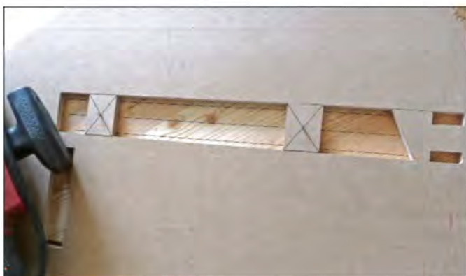
10 Le positionnement du gabarit « d'entailage »
