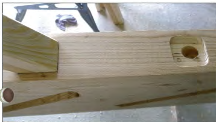
30 Réalisation des encastements
