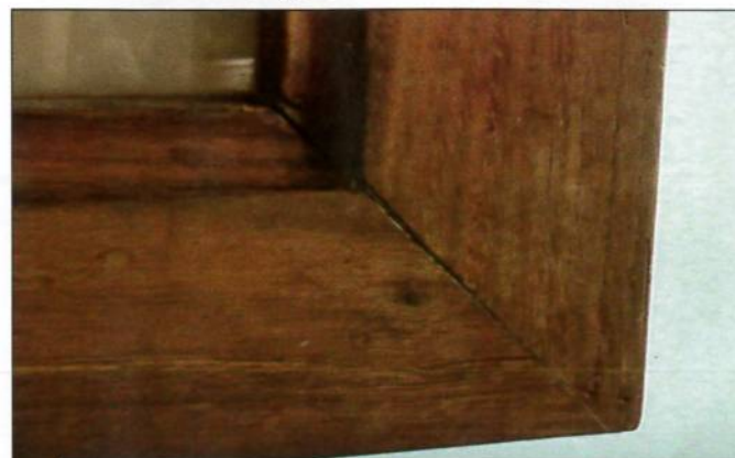
20 Détail d'assemblage d'un cadre
