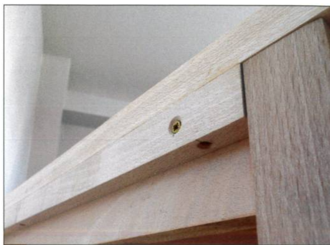
14 Fixation de la tablette supérieure
