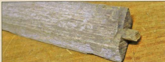
9 Ce témoignage du passé laisse deviner le mode d'assemblage des lames à l'époque
