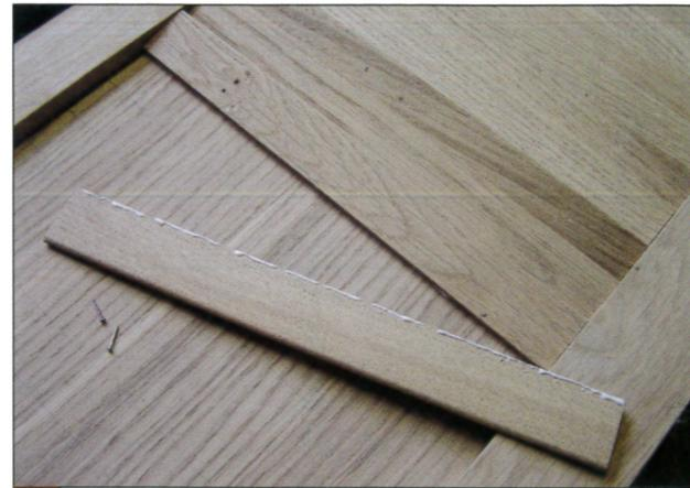
27 Collez et pointez les lattes. Les pointes sont cachées par le recouvrement de la latte suivante.
