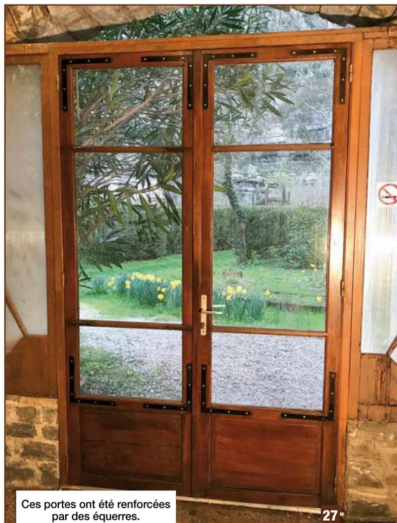
**Solution :** renforcer avec des équerres. J'en ai trouvé de bonnes en quincaillerie : 225 mm de long, section 25 x 4 mm. Pour les quatre coins de deux portes à deux battants chacune, il me fallait 16 équerres, et autant d'entailles ! J'ai dépaumellé les portes, les ai posées sur tréteaux, et remis d'équerre avec des grands serre-joints installés hors d'équerre (voir schéma ci-dessous). Restait à poser les équerres.
