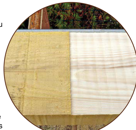
La panne en cours de dressage, par passes transversales.
