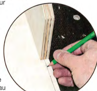
Repérage de l'axe des cloisons sur le support.
