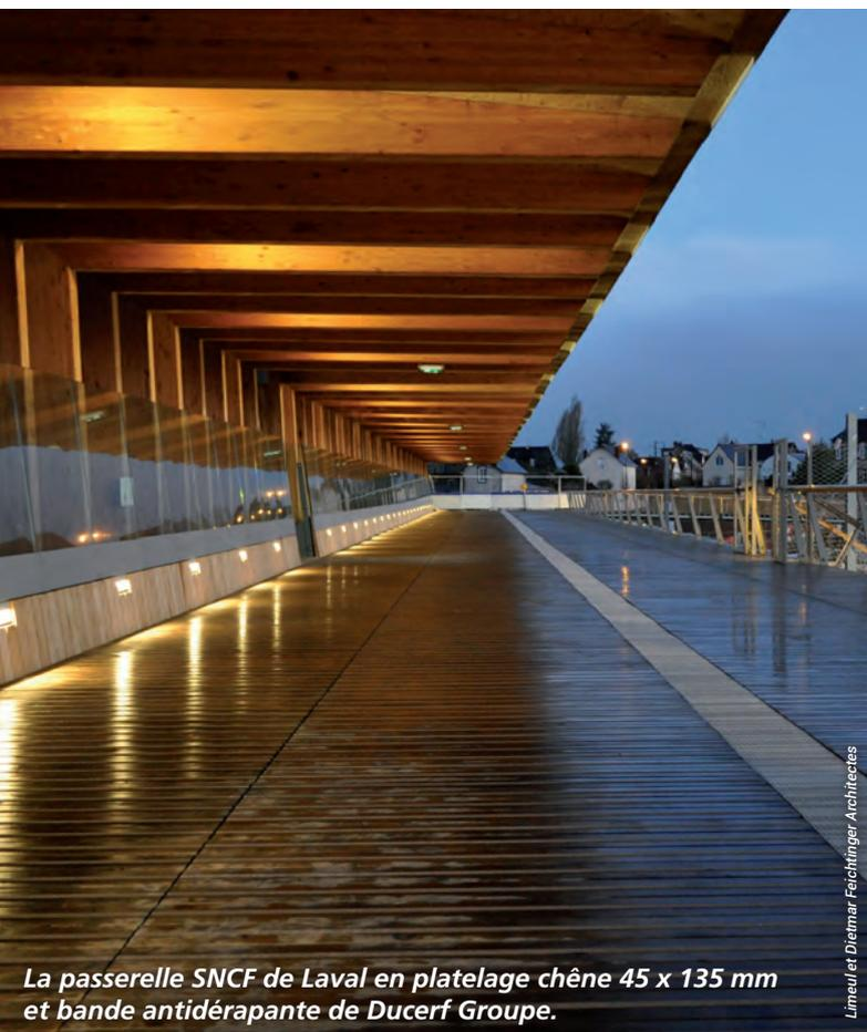
La passerelle SNCF de Laval en platelage chêne 45 x 135 mm et bande antidérapante de Ducerf Groupe.
