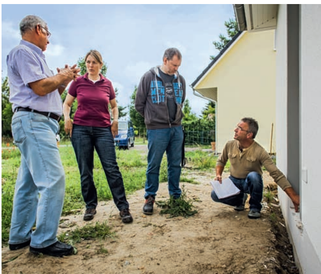
Zur vorläufigen Abnahme kamen der Bauleiter (rechts) und Bauherrenberater Dipl.-Ing. Reiner Uelze (links), der seine Kollegin Carola Giertz vertrat.
