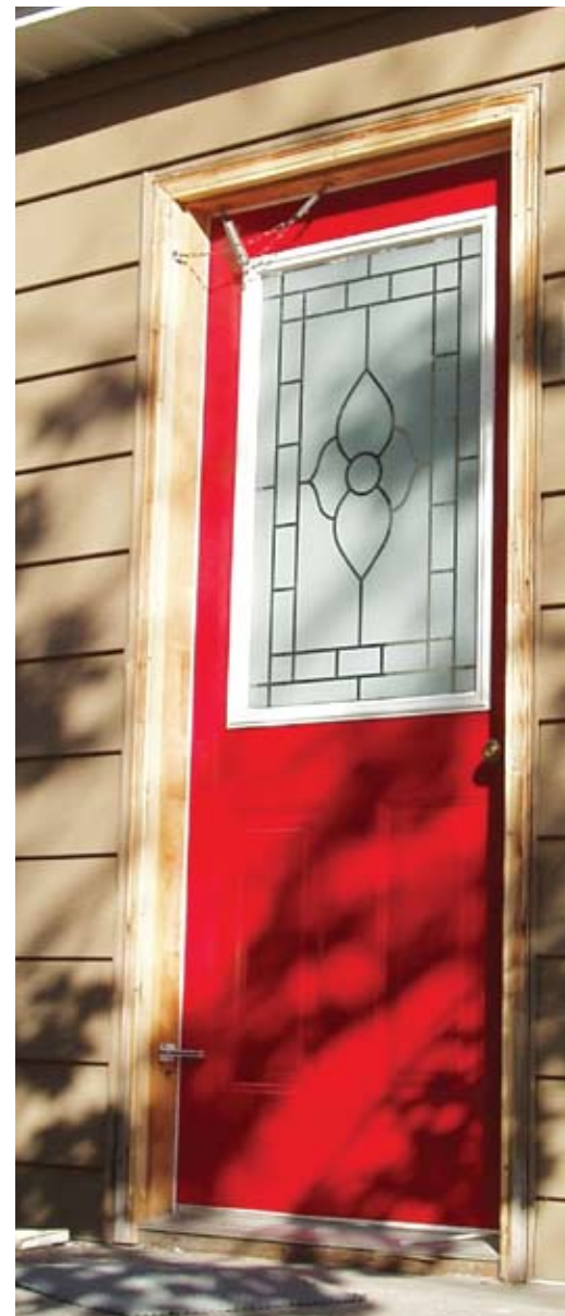
Original door frame
